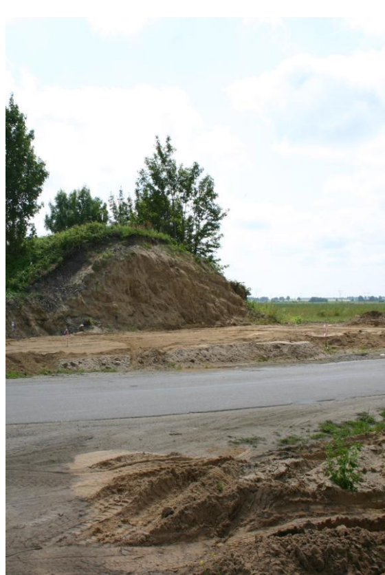
f) dawny nasyp kolejowy na północny-zachód od Sławna
