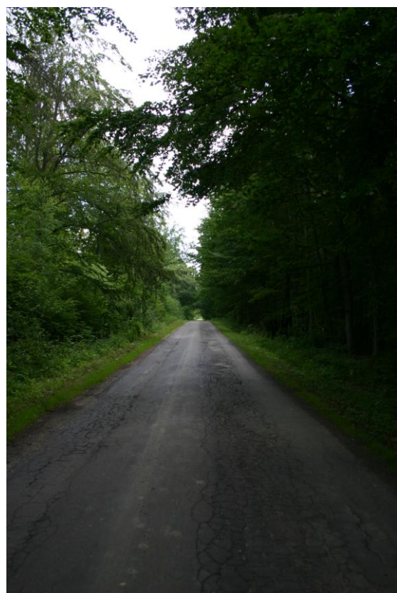
b) śródleśna droga asfaltowa w rejonie Krzemienicy
