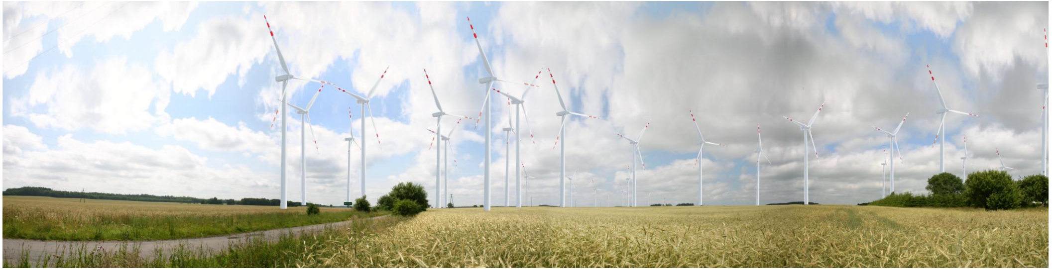
Fot. 3 Widok na teren lokalizacji Farmy Wiatrowej >Zachód< (zespół >Sulechówko<), z miejscowości Darskovo – wmontowane sylwety elektrowni wiatrowych (odległość do elektrowni od ok. 600 m do 2 km – zespół >Sulechówko< i od ok. 3,2 km do ok. 4,5 km - >Bartolino<, elektrownie zespołu >Przystawy< niewidoczne za wyniesieniami terenu i zadrzewieniami – odległość ponad 10 km)
