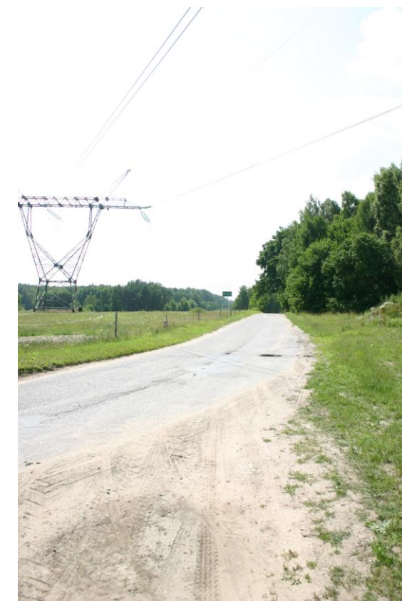
e) droga asfaltowa Staniewice-Nosalin, w rejonie doliny Wieprzy
